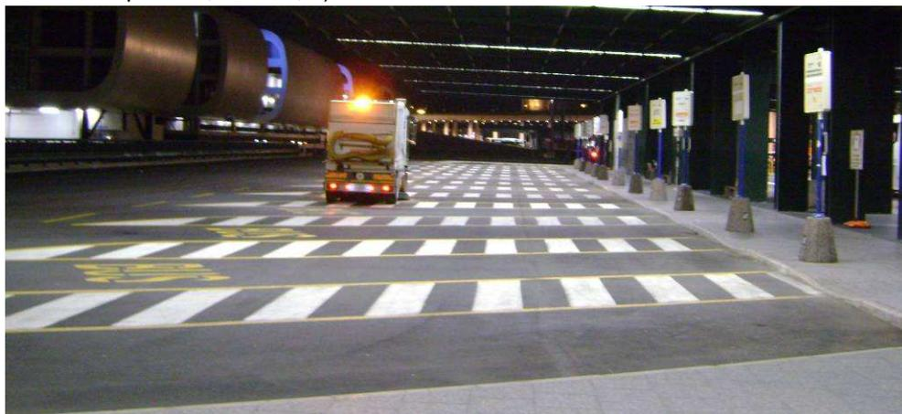
2. Pulverización del spray fotocatalítico sobre la rodadura o acera existente, mediante maquinaria patentada, que lo fabrica (micro-emulsión) y lo extiende. La formulación y la dotación del spray varían en función del tipo de soporte de aplicación.
